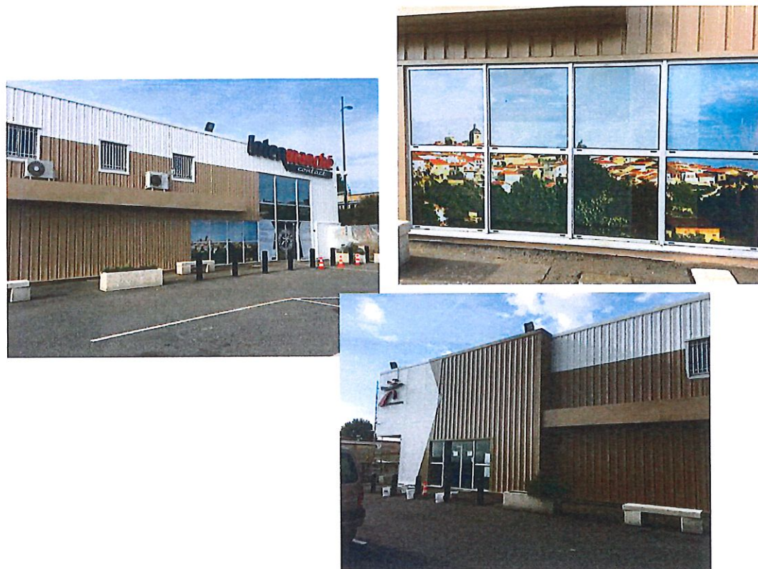
Etat du site en 2019 depuis sa rénovation partielle en attente du transfert
